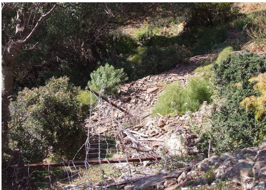
Fig. 12, crollo della recinzione dell'area di proprietà della società RWM a nord dello stabilimento a causa degli accumuli franosi sulla stessa, coordinate circa 39°21'24.8"N 8°40'41.2"E, foto del 25/04/2023
